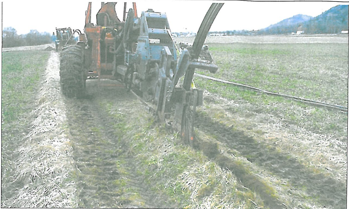
Einmal quer durch den Acker: an manchen Passagen mussten die Glasfaser-Kabel doch noch konventionell verlegt werden – hier mit dem Pflug.
